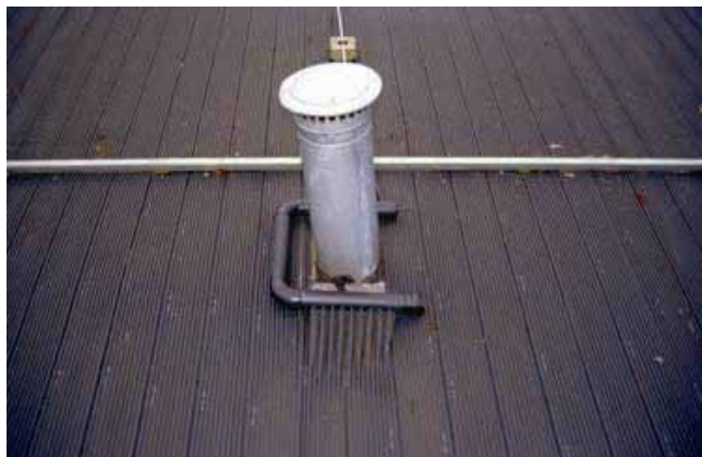
Figura 7.4 - Um by-pass na zona da chaminé com um absorvedor de tubo EPDM
