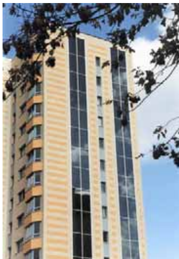
Figura 8.8 - Sistema de aquecimento ambiente solar em Breite Strasse, Potsdam
