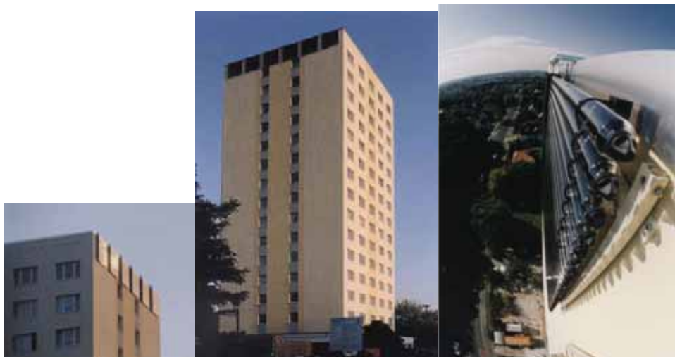
Figura 5.12 - Instalação em fachada de colectores de tubos de vácuo
