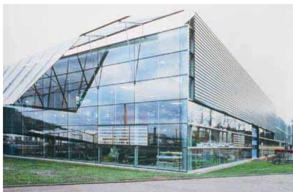
Figura 8.3 - Escritórios e instalações de produção na MBE Metallbau Eisenach, com uma fachada solar
