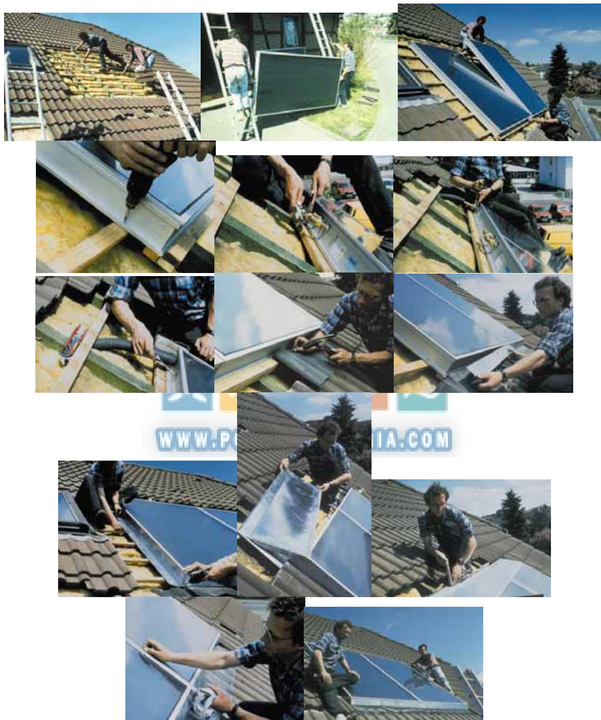
Figura 5.6 - Exemplo de instalação integrada
