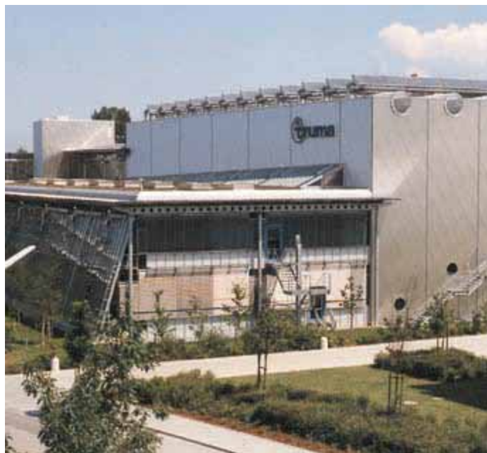
Figura 8.2 - Colectores de aquecimento ambiente em suportes no telhado de uma fábrica
