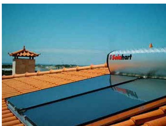
Figura 3.30 – Sistema termossifão
