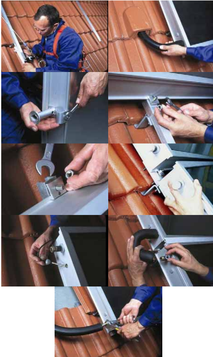
Figura 5.5 - Instalação sobre o telhado
