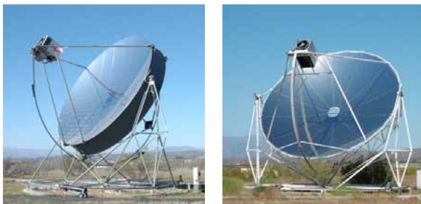
Figura 6.33 - Sistemas de demonstração Dish/Stirling em Almería (Sul de Espanha)
