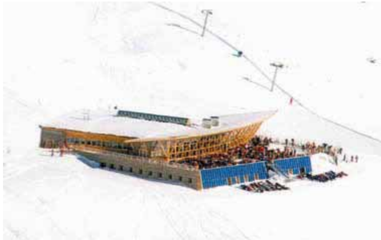
Figura 5.11 - Instalação em fachada de uma grande superfície de colectores coloridos
