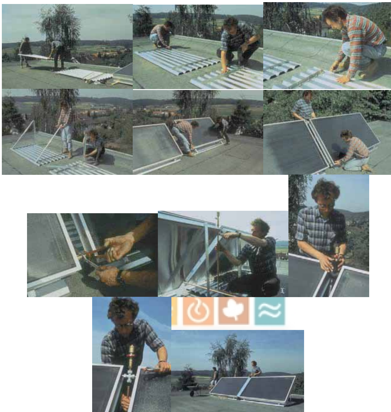
Figura 5.7 - Instalação em telhado plano
